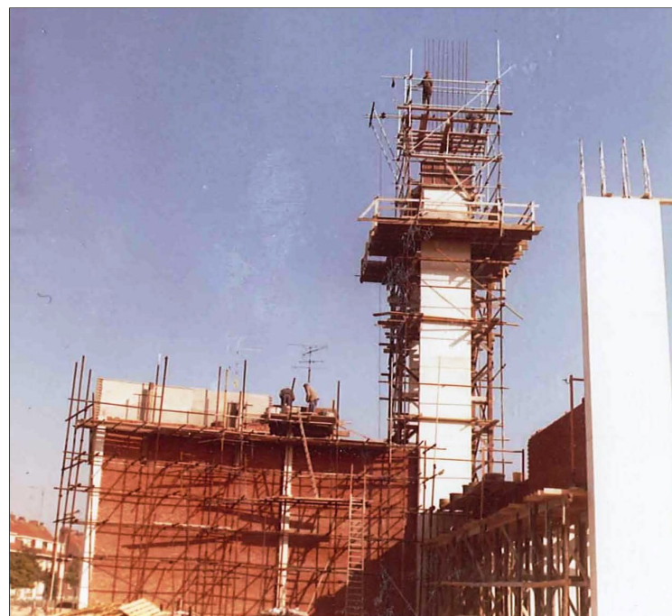
Een deel van de achtermuur en klokkentoren (c) Jos Ritzen
